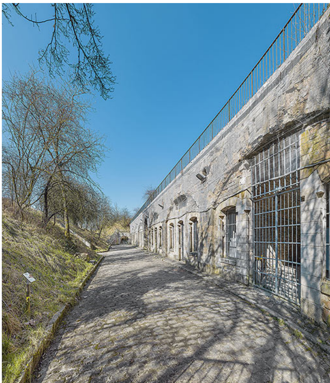
Le casernement de la redoute.
