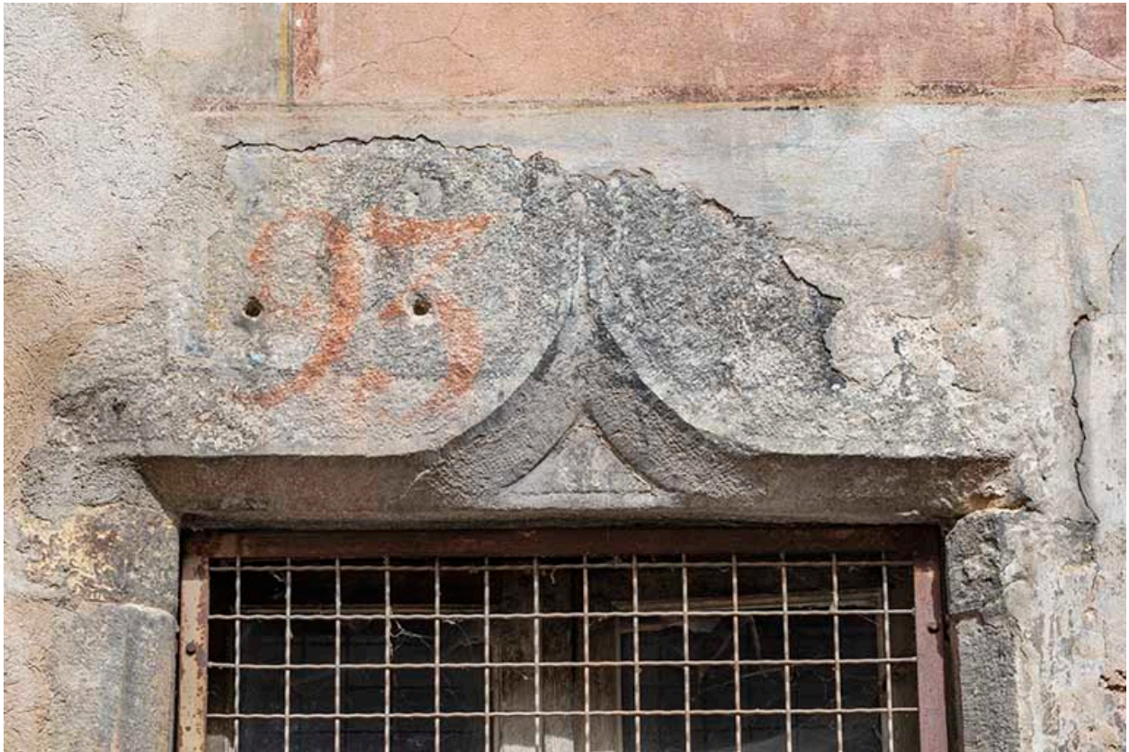
Façade sud. Linteau portant l'inscription peinte (ancienne numérotation).
