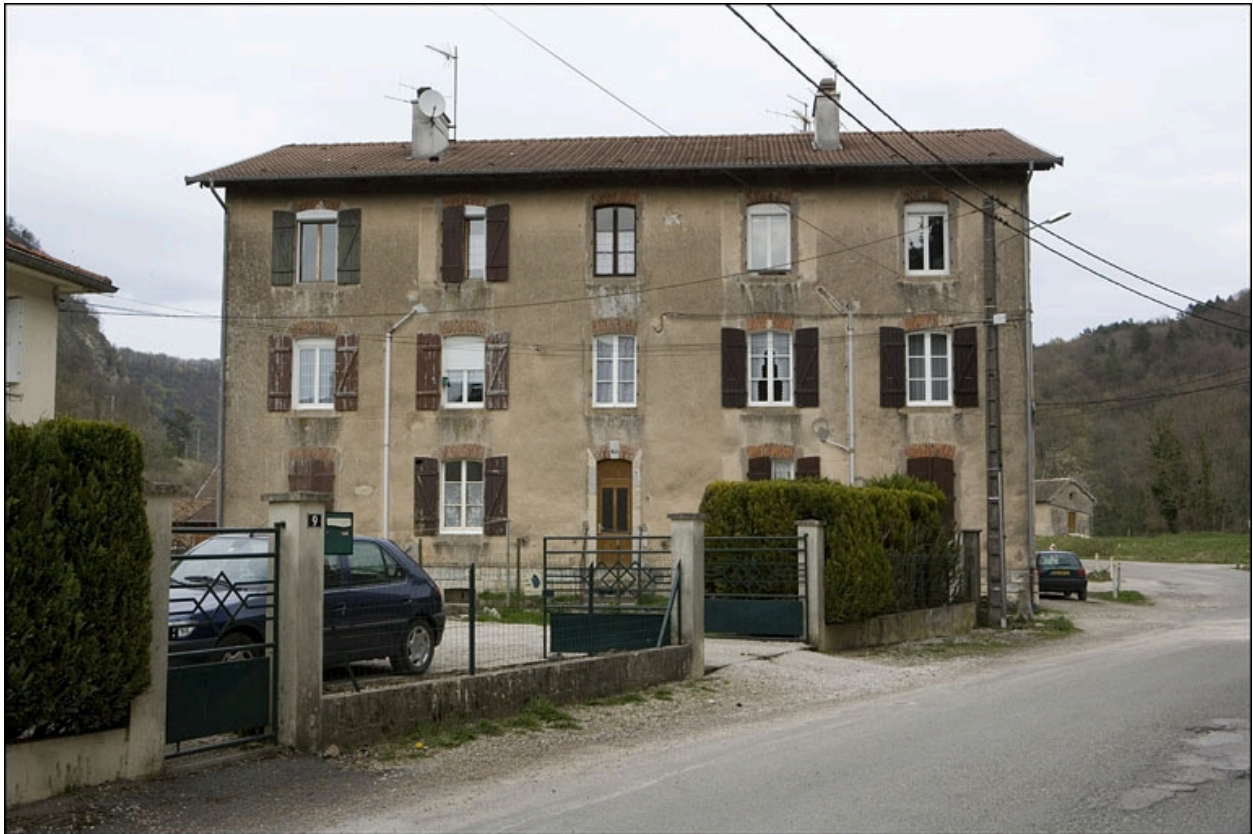
Cité ouvrière (rue des Ecoles). Façade sud.
