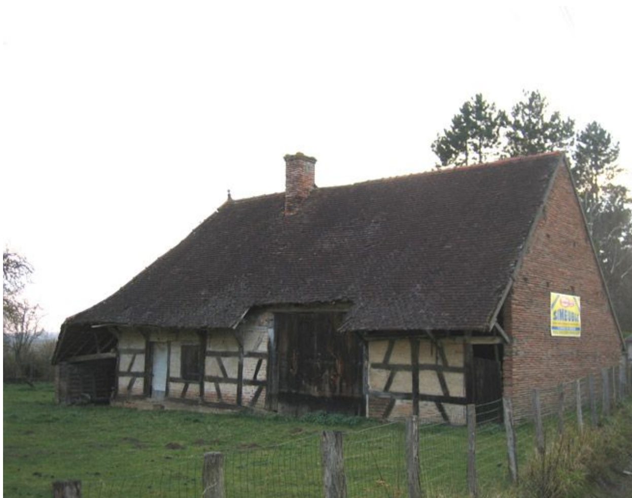
Vue d'ensemble de la façade.
