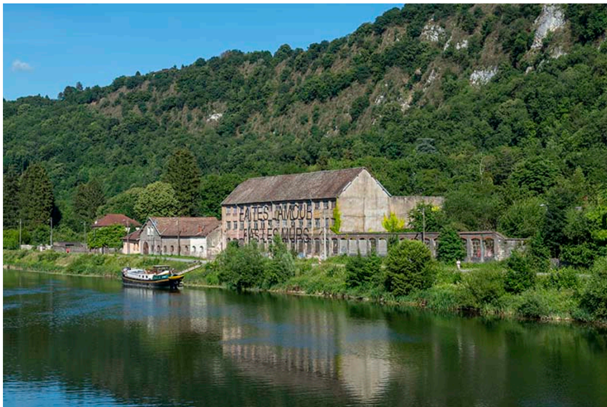
Vue rapprochée depuis l'ouest.
