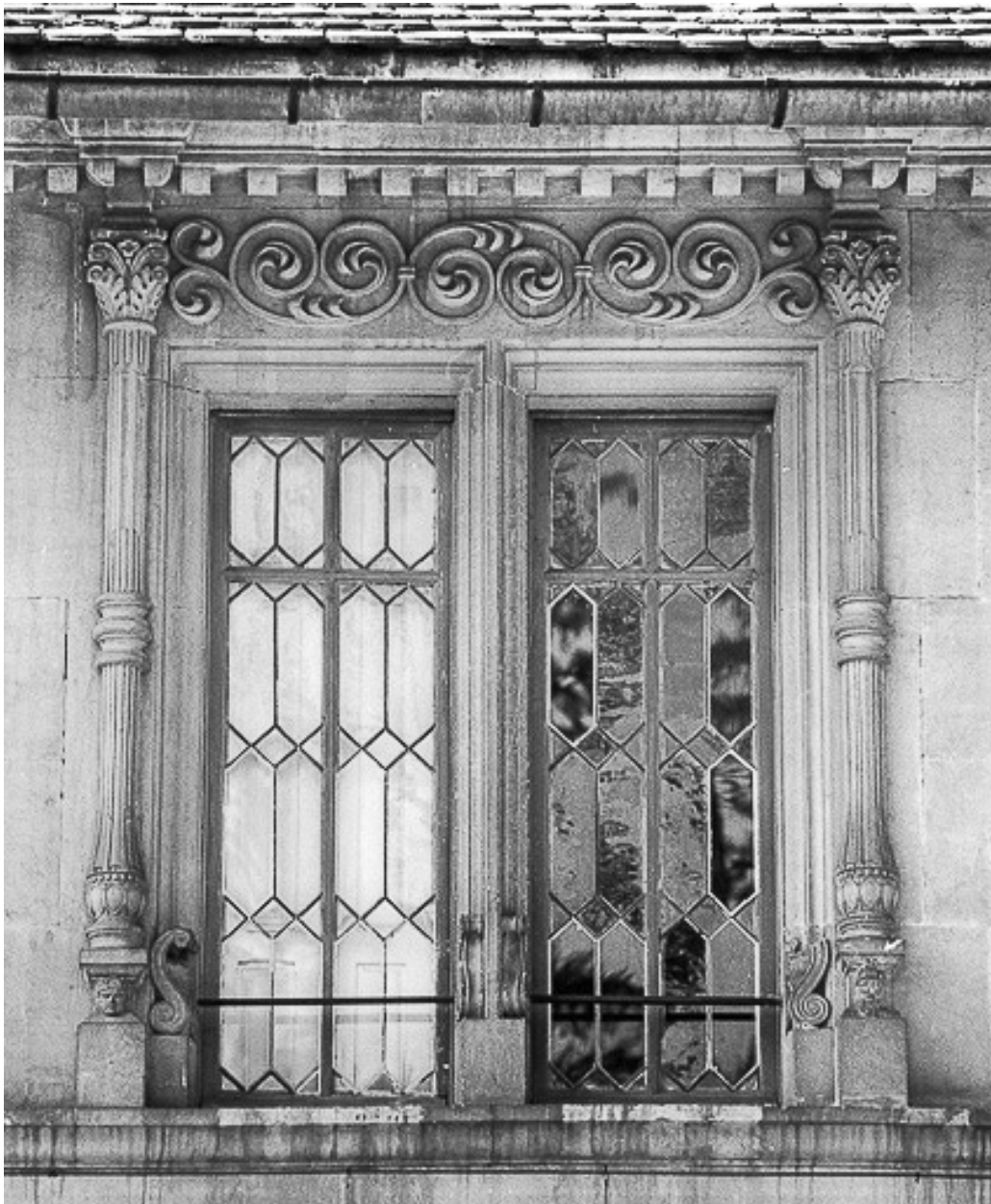
Fenêtre sur rue, à l'étage.
