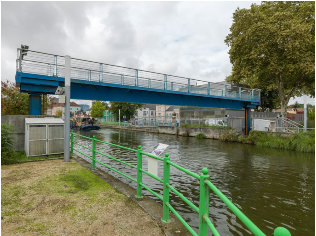
Passerelle remontée après le passage d'un bateau.
