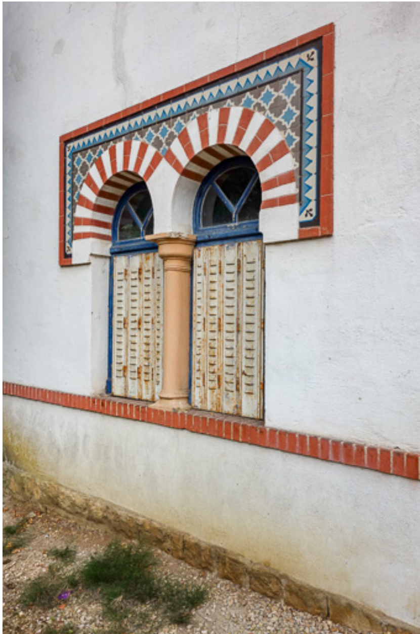
Élévation du pavillon du gardien, baies jumelées du rez-de-chaussée.
