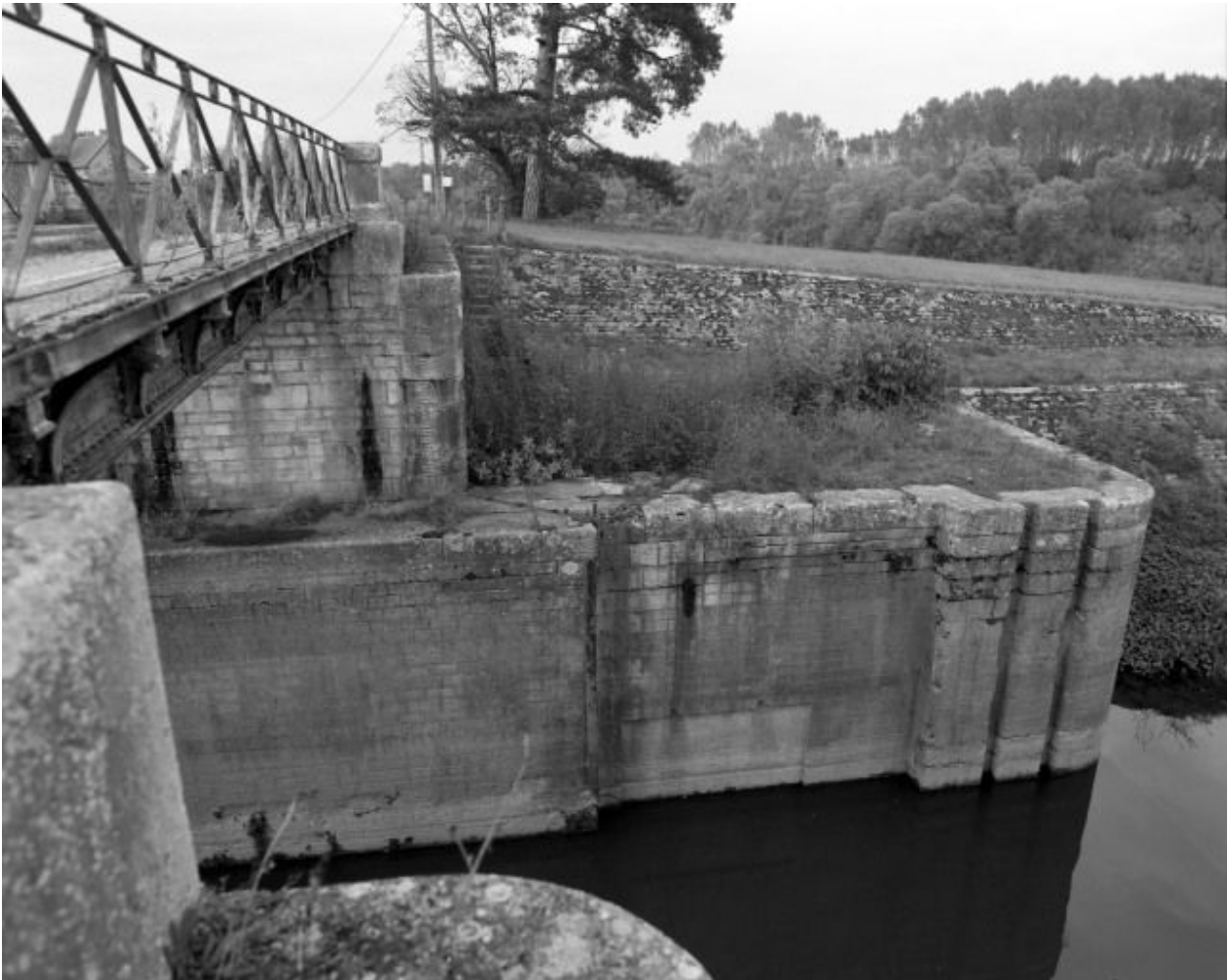
L'entrée est de l'écluse en 2001, détail.
