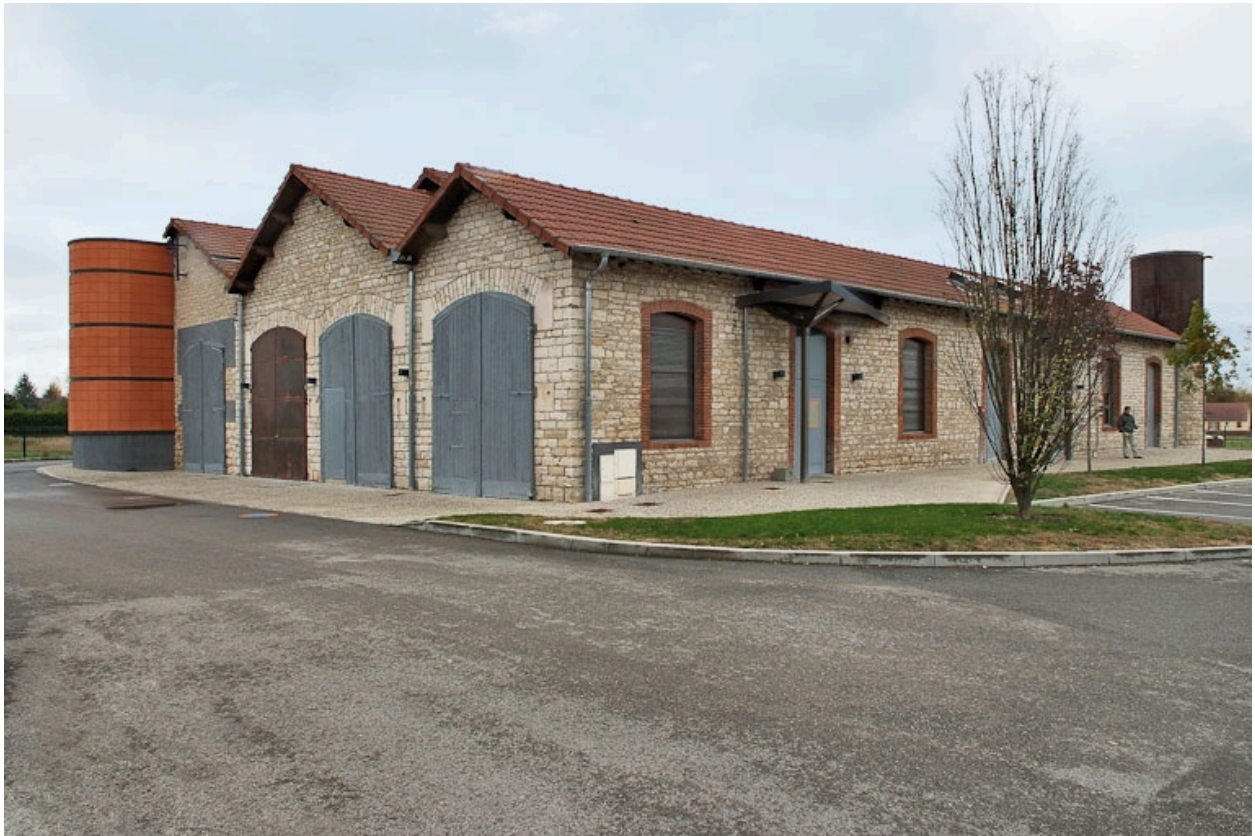
Vue d'ensemble du bâtiment.
