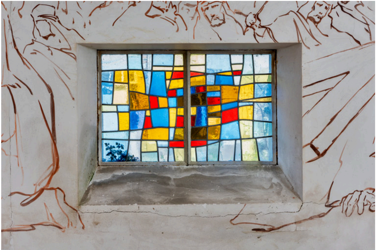
Vue d'une verrière (baie 1).
