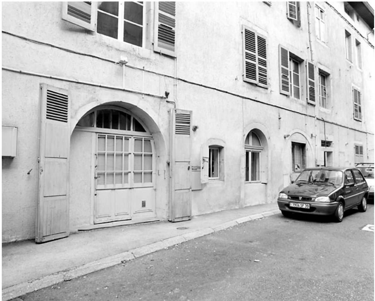
Elévation postérieure : baies du rez-de-chaussée.
