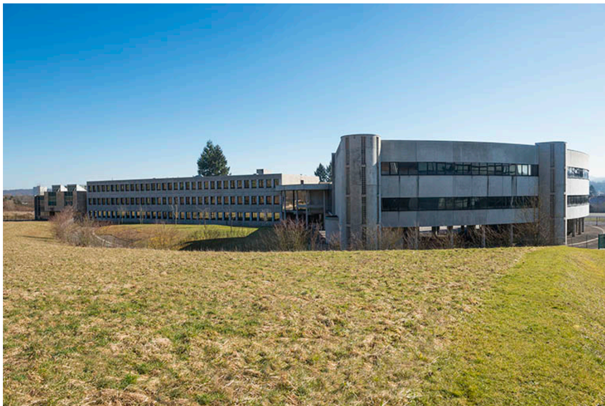
Vue d'ensemble des façades ouest.
