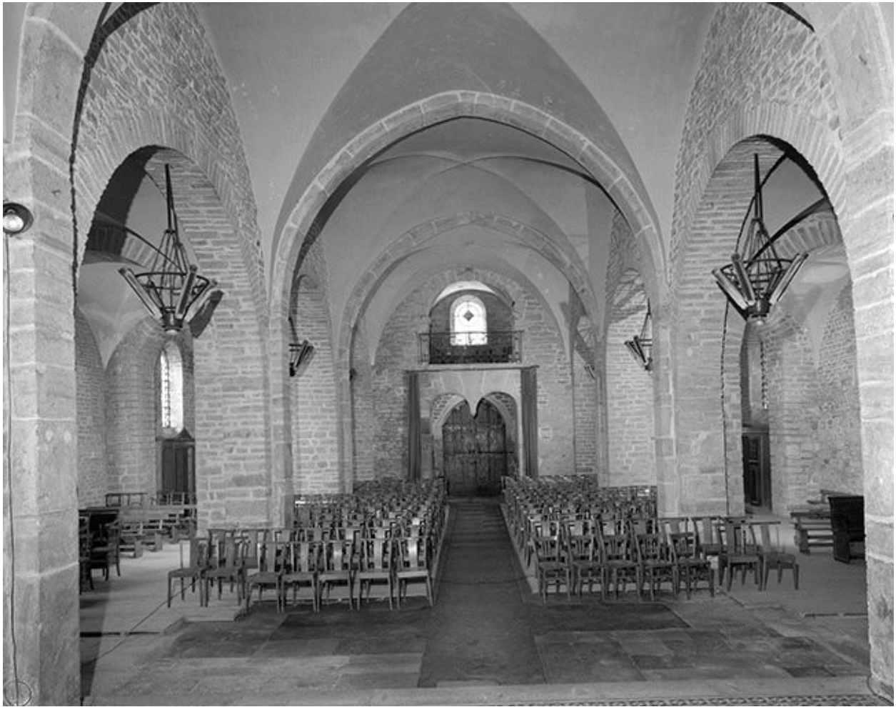
Nef vue depuis le chœur.
