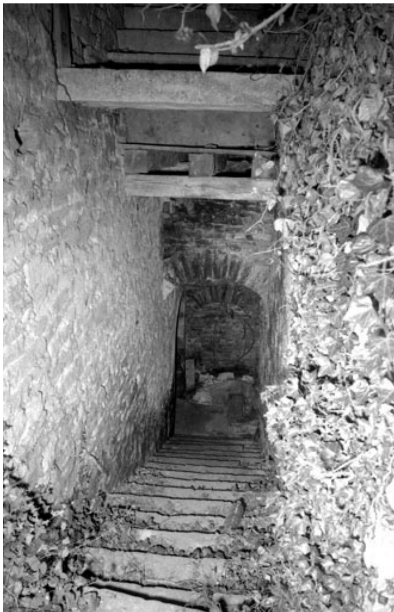
Partie habitation : escalier menant à la cave.
