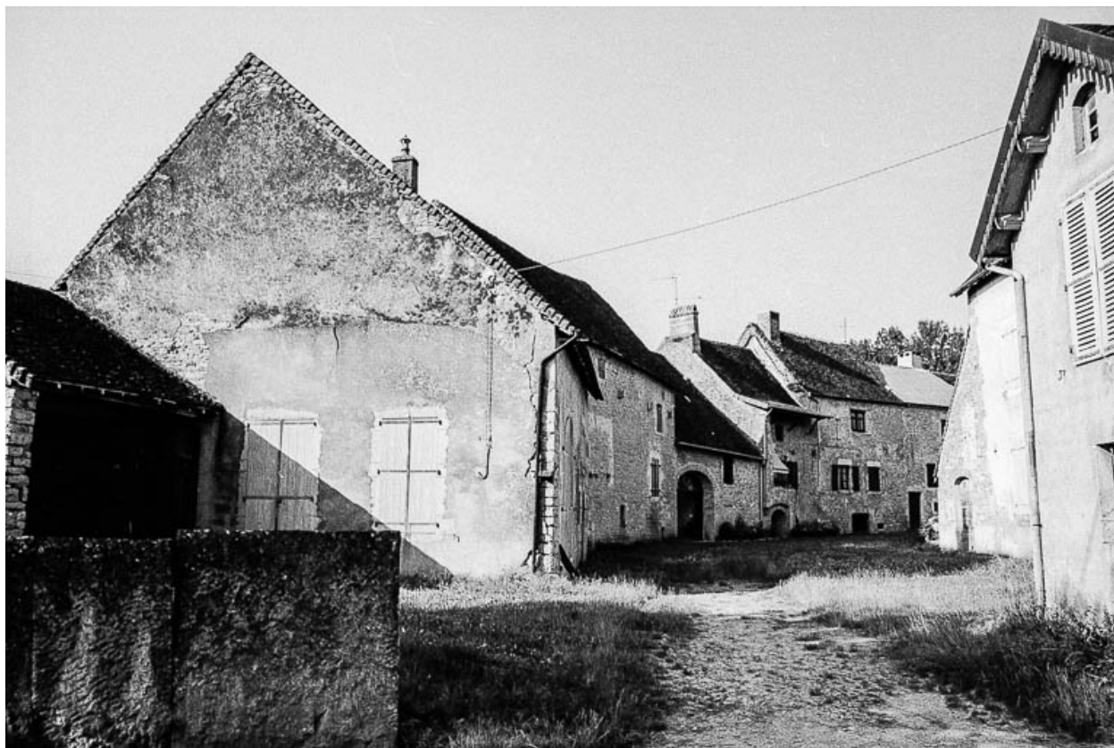
Maisons cadastrées 1960 AI 97 à 101, situées rue du Puits : vue d'ensemble.
