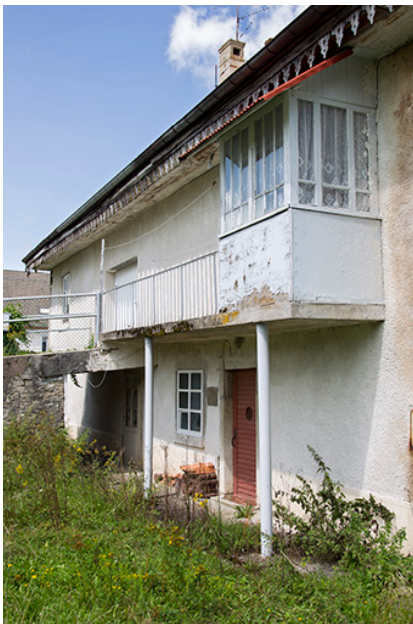
Façade postérieure, vue en enfilade depuis la droite.
