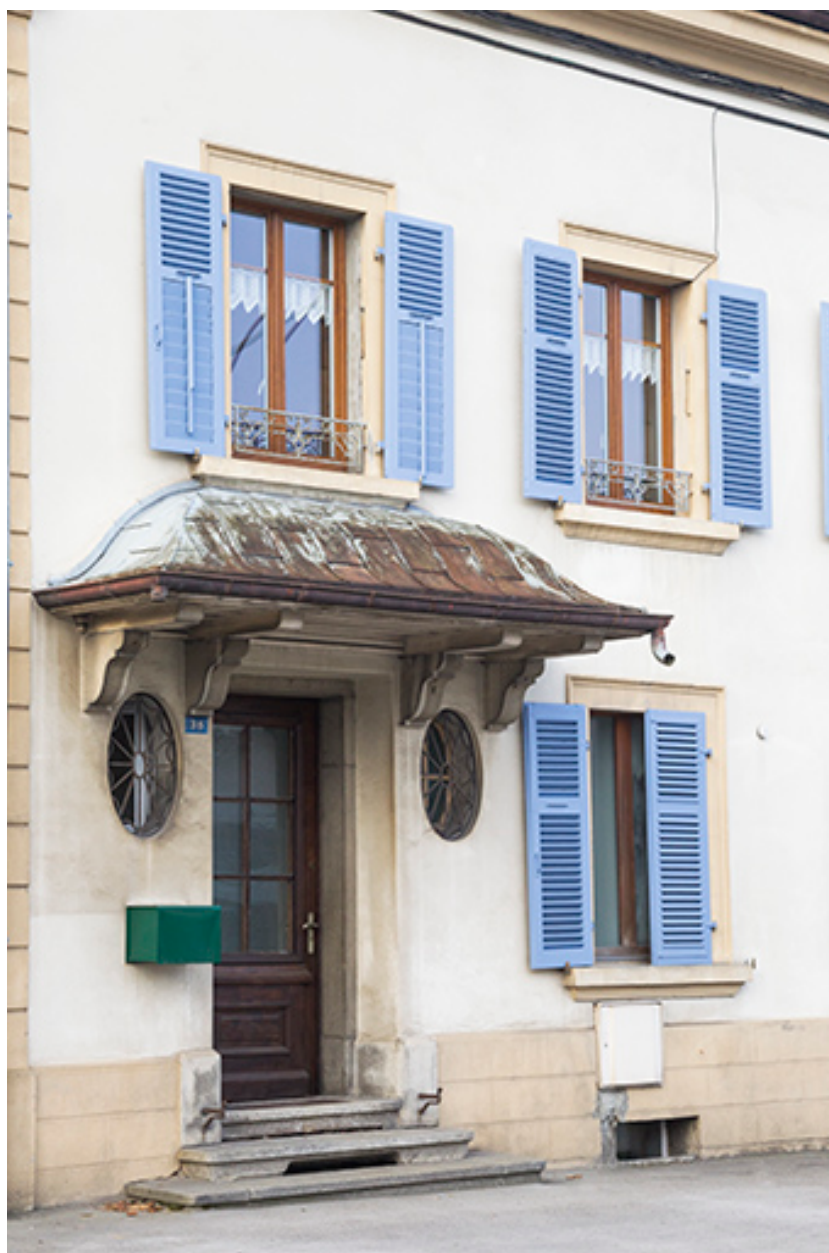
Façade antérieure : entrée du logement patronal.
