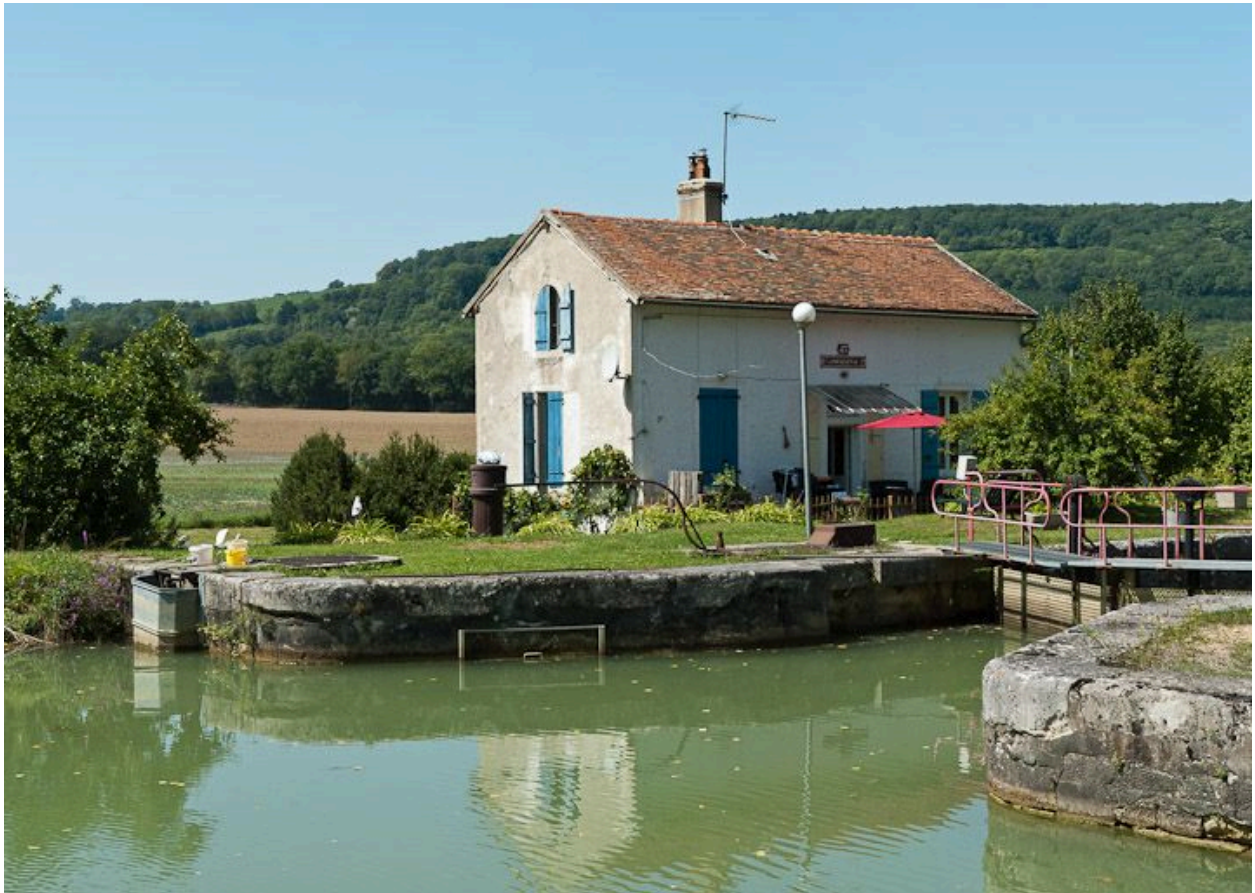
Vue du site d'écluse depuis l'amont.
