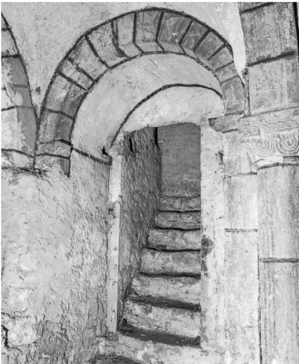
Crypte : escalier menant à la nef.
