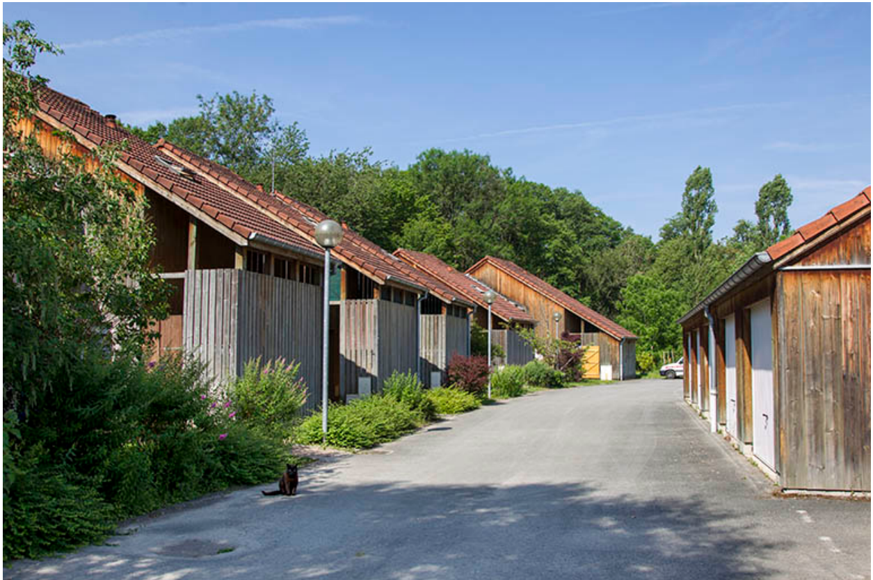
Façades nord des logements du site d'exploitation.
