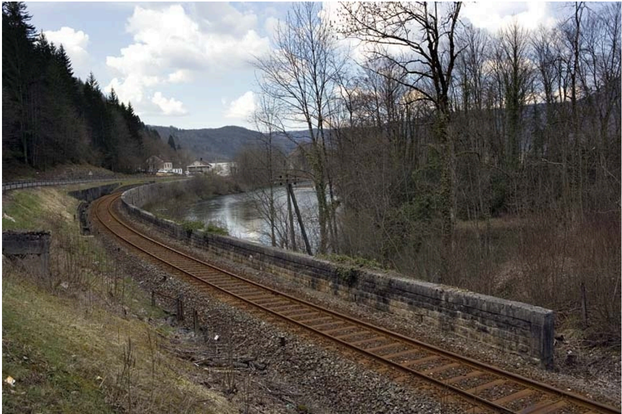
Vue d'ensemble, depuis le côté Andelot-en-Montagne.
