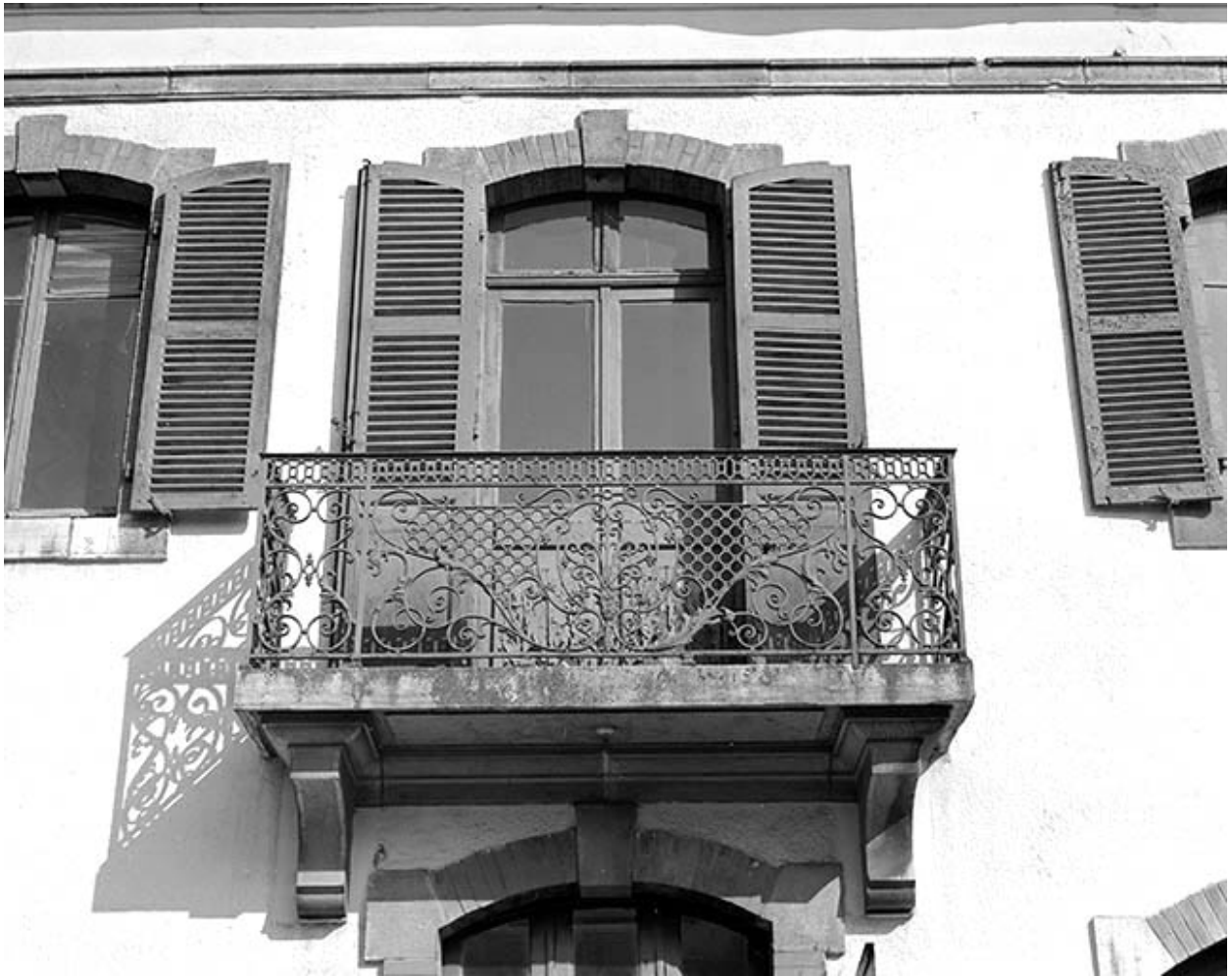
Balcon des bureaux (extrémité occidentale), baie volets ouverts.
