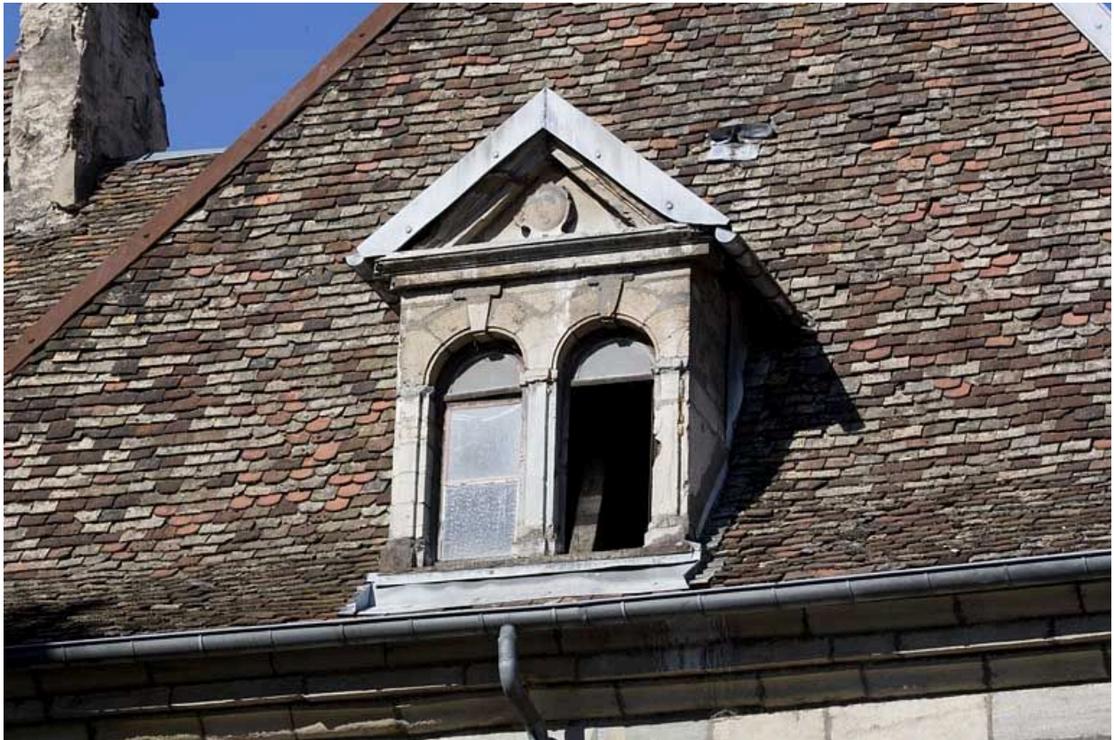
Détail de la lucarne.
