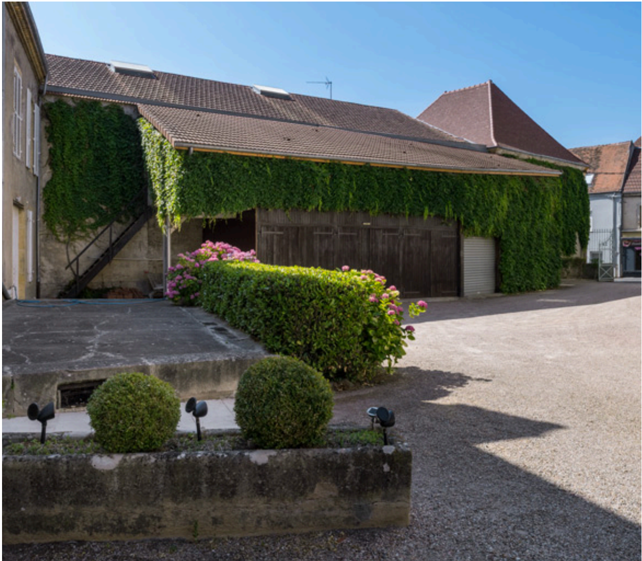
Façade latérale gauche, depuis une cour à l'est.
