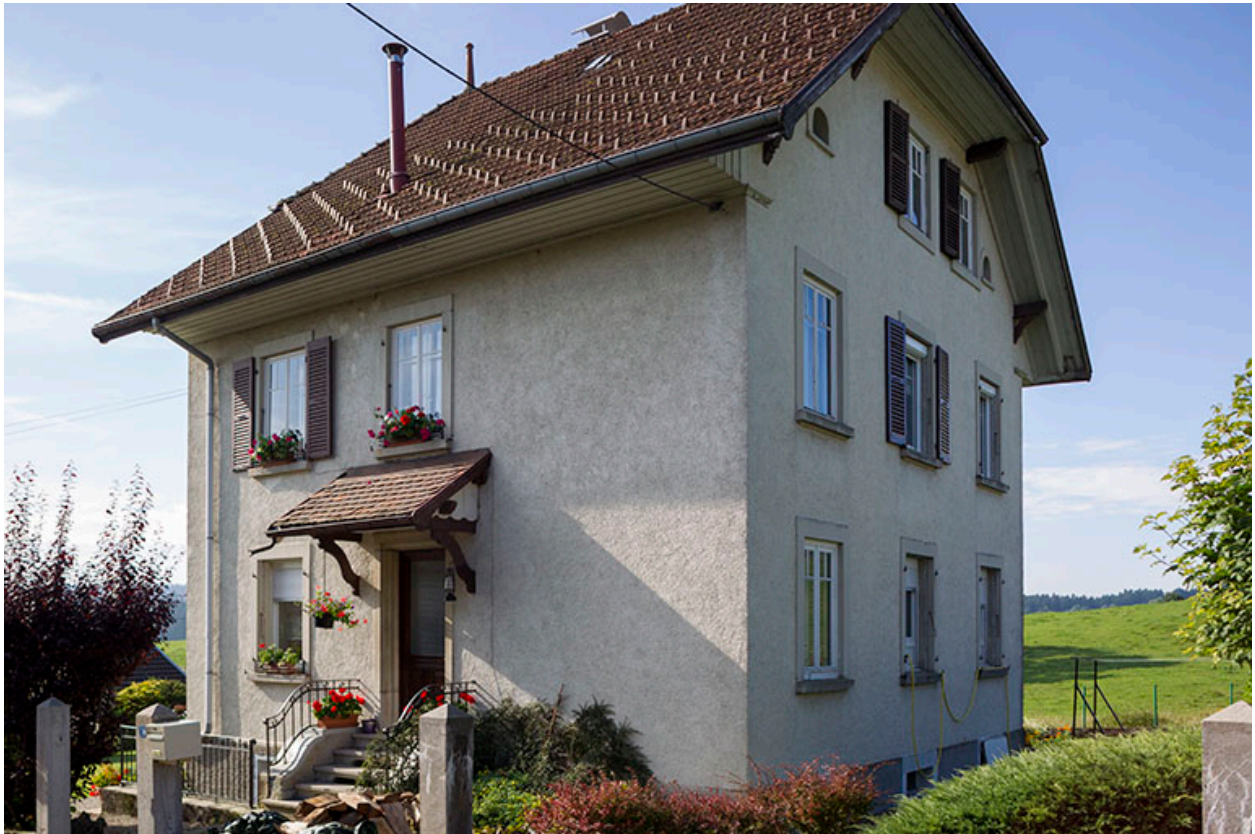
Façades antérieure et latérale droite.
