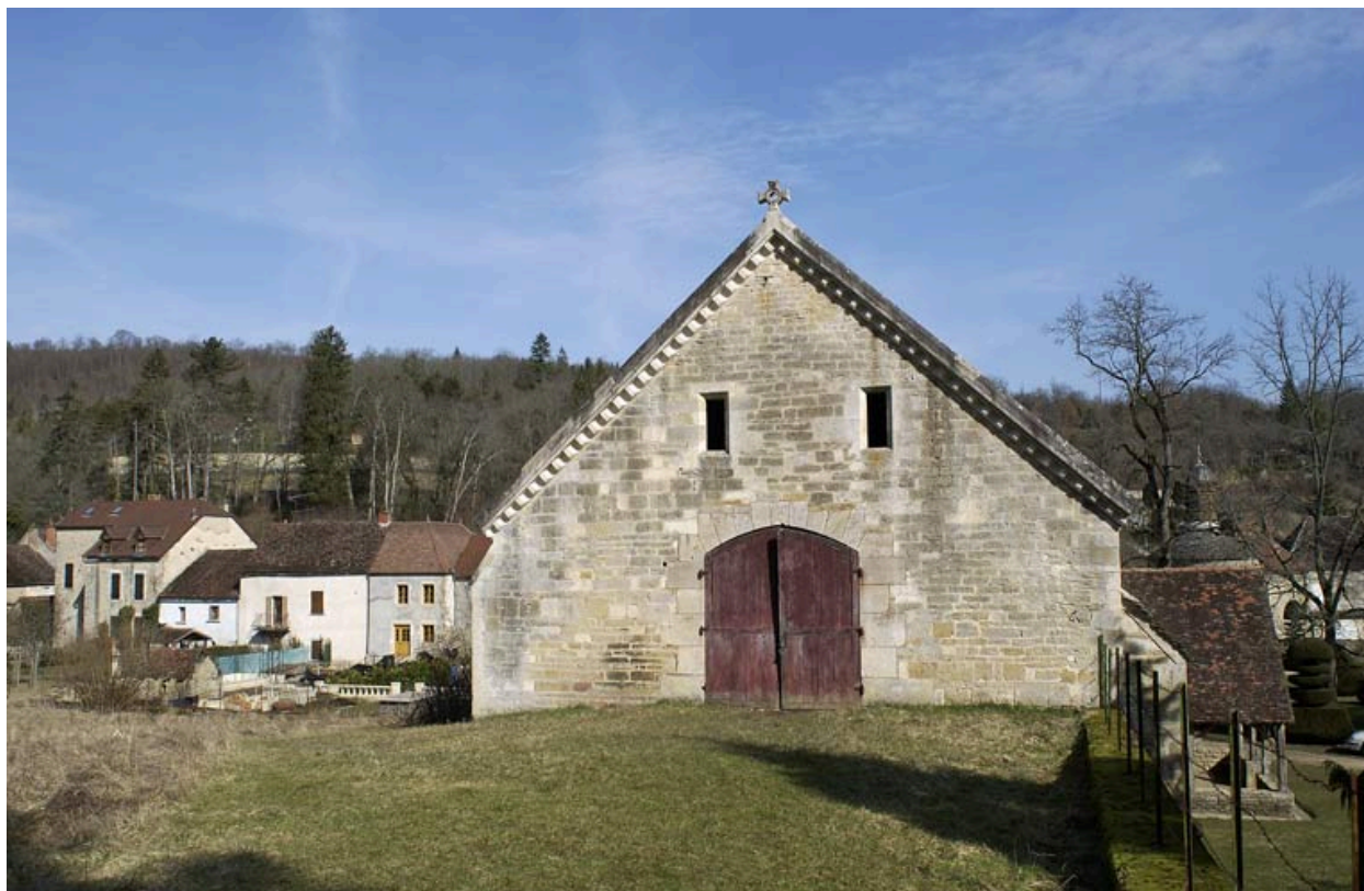
Cellier : mur pignon sud.
