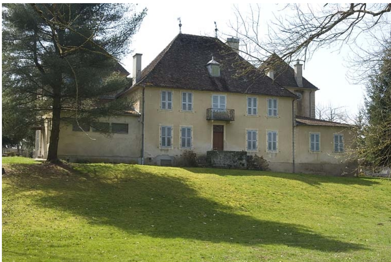
Façade postérieure du logement patronal.
