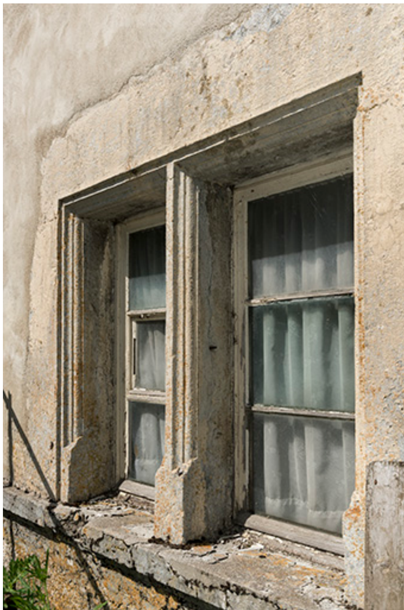
Façade est : fenêtres jumelées à encadrement mouluré.
