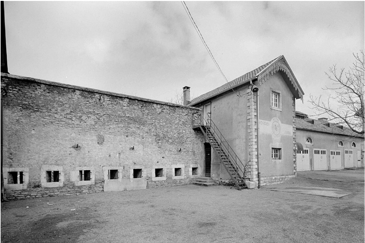
Enceinte. Partie vue de la basse-cour (p).
