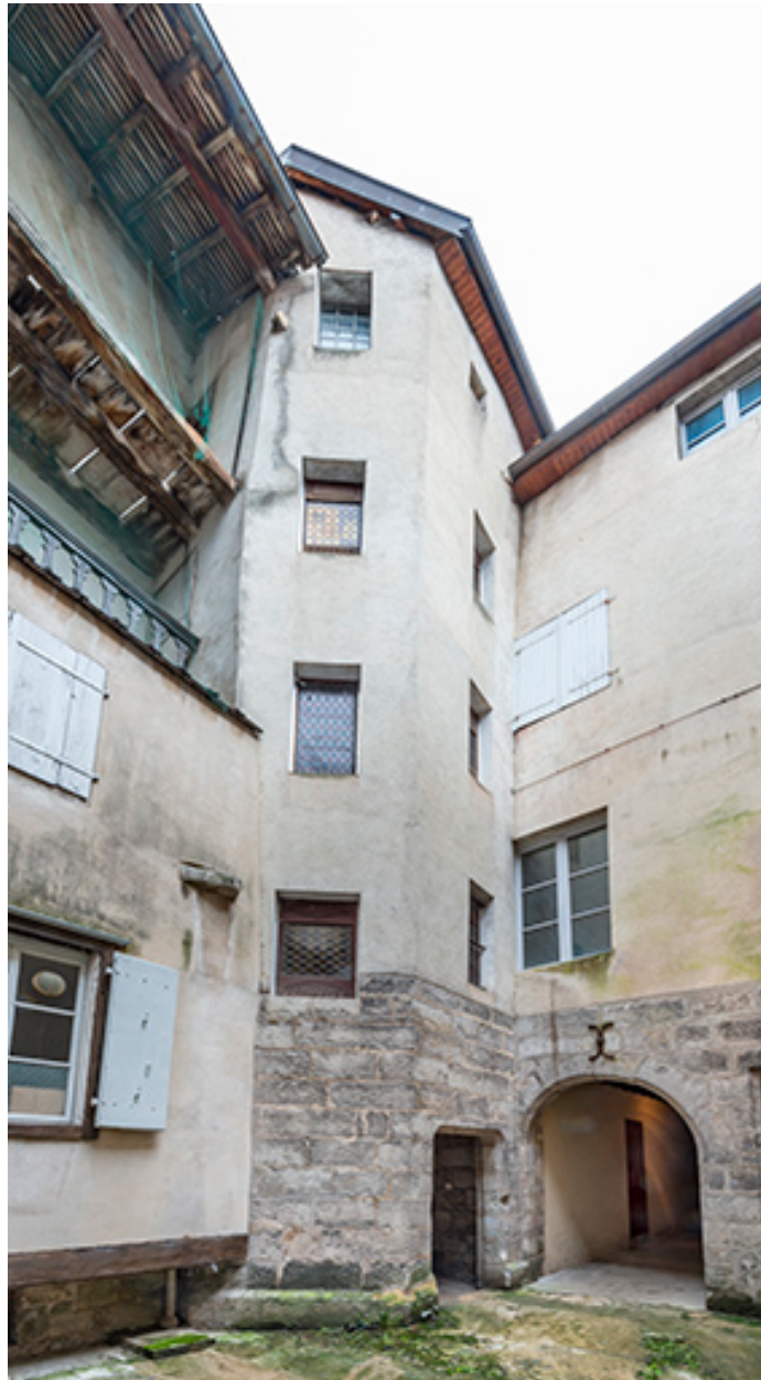
Tour d'escalier polygonale, depuis la cour.
