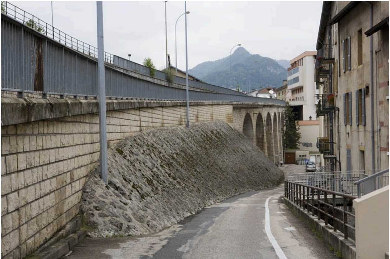
Vue d'ensemble depuis le sud, avec le perré au premier plan.
