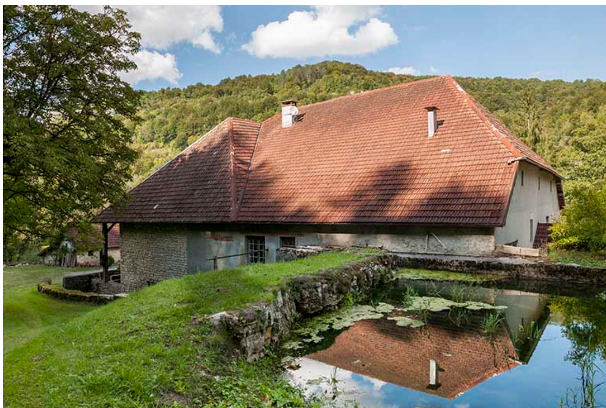
Vue plongeante depuis le sud-est.
