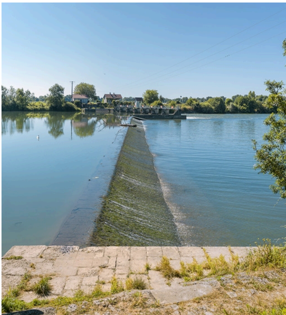
Le déversoir du barrage.
