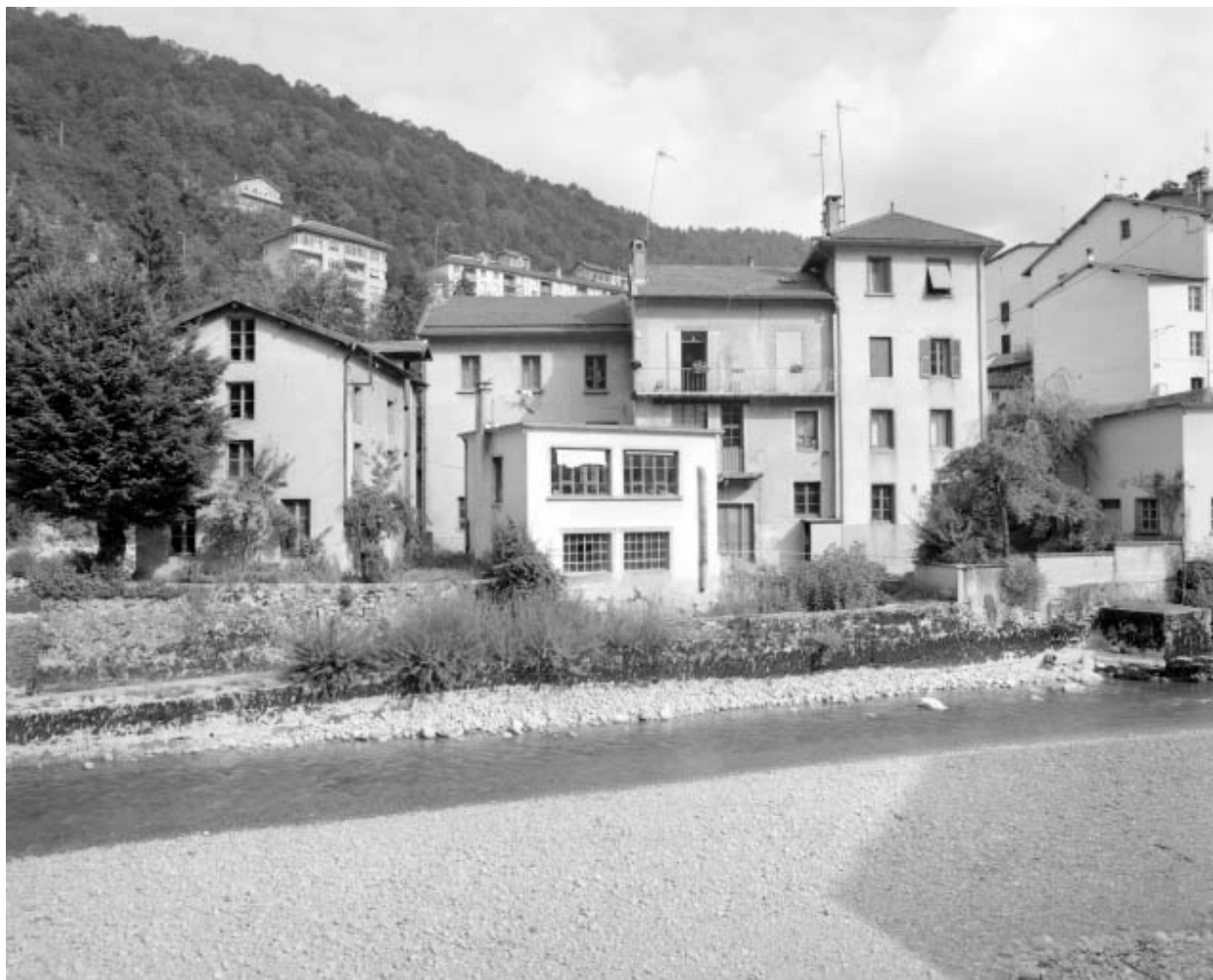
Bâtiments vus du sud-est.
