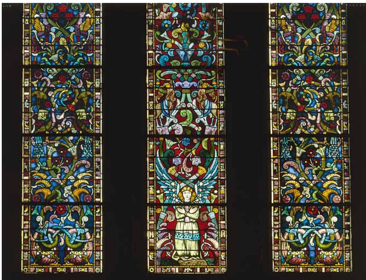
Baie 8, partie basse : Sacré Coeur de Jésus.
