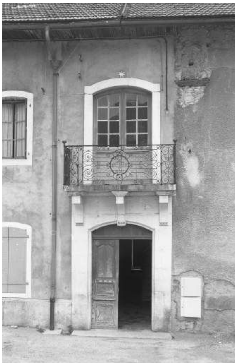
Logement patronal : porte d'entrée et balcon.
