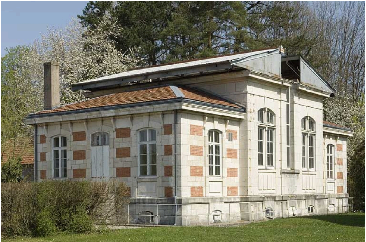
Pavillon de la méridienne, toiture ouverte.
