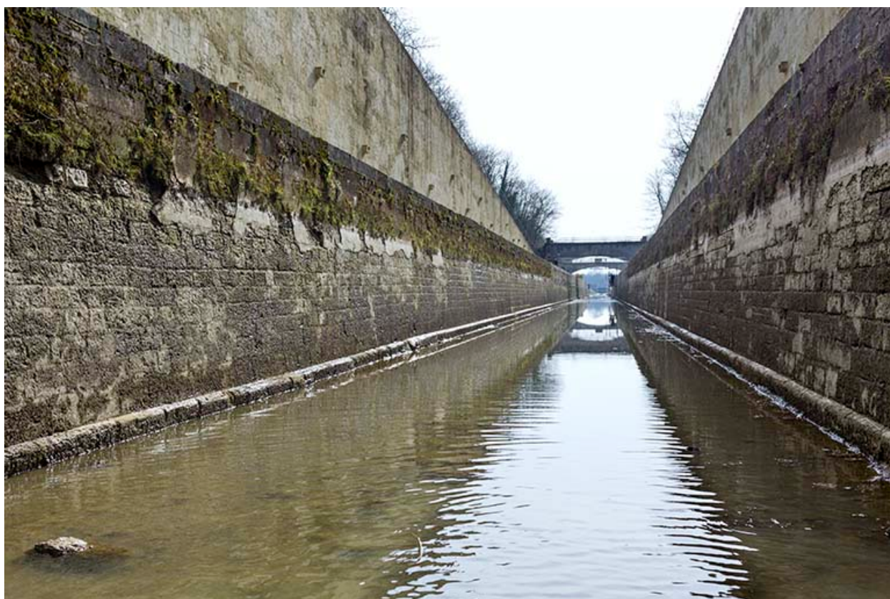
Le canal, vue prise depuis le radier.
