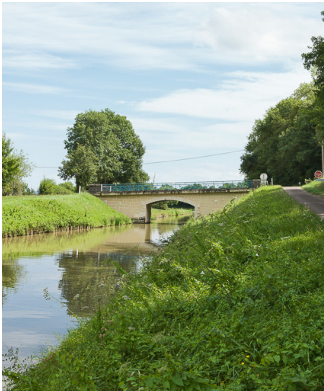
Vue d'ensemble du pont et du site.
