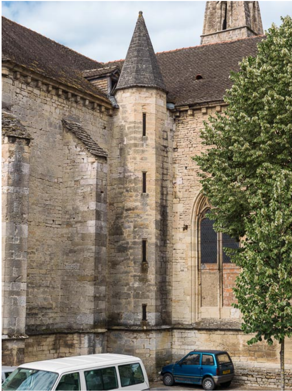
Vue de la tourelle d'escalier.
