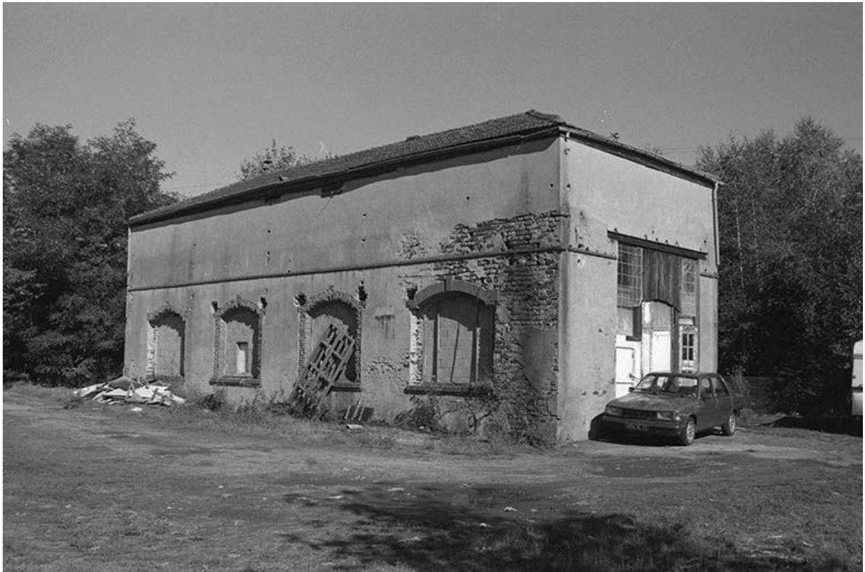
Salle des machines, vue du sud-ouest.
