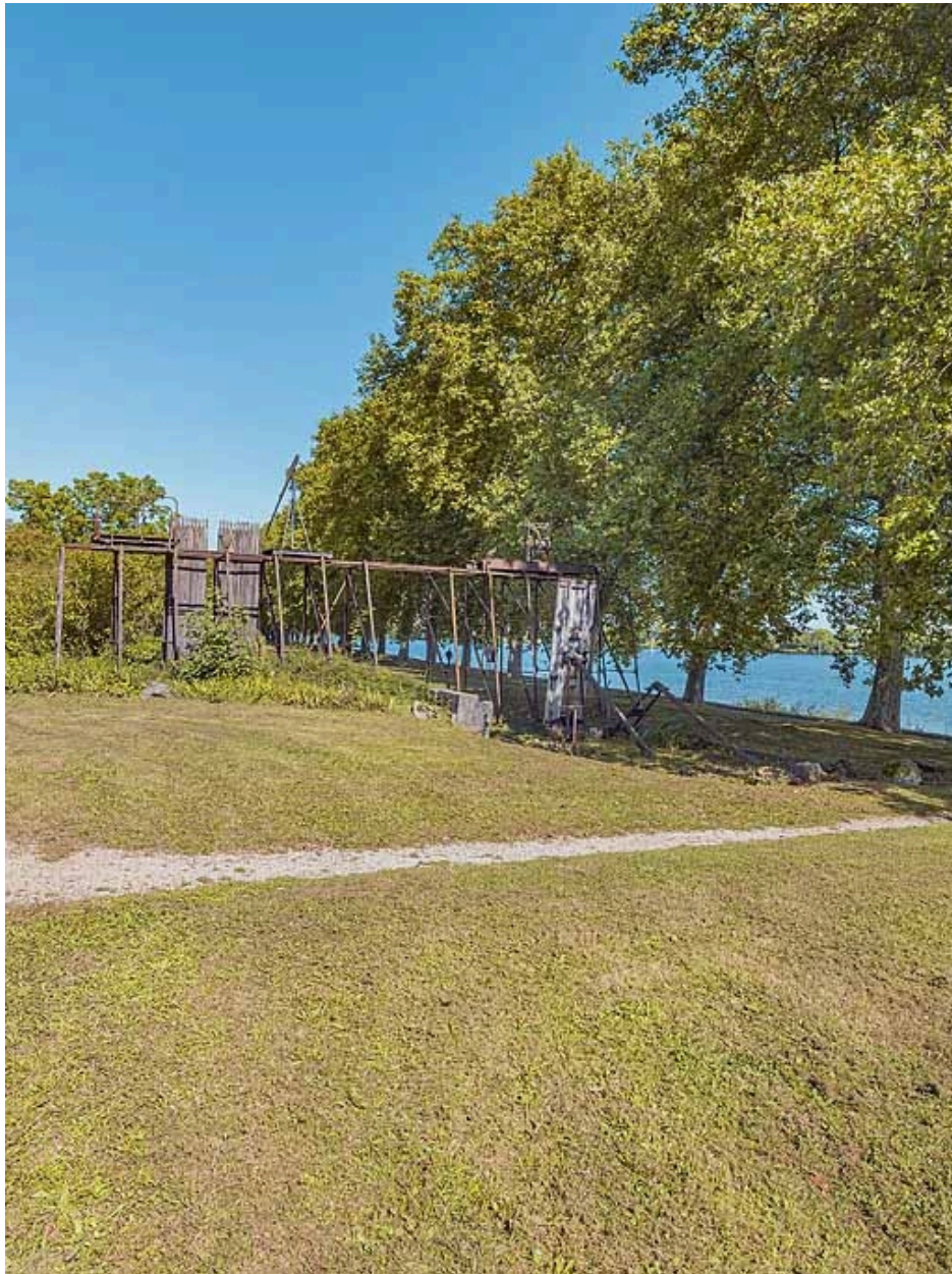
Les vestiges de l'ancien barrage de Thoissey, à Mâcon.
