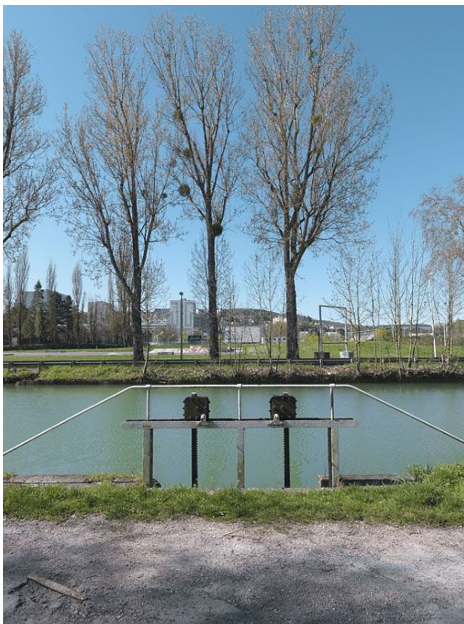
Déversoir du canal dans l'Ouche : vannes.
