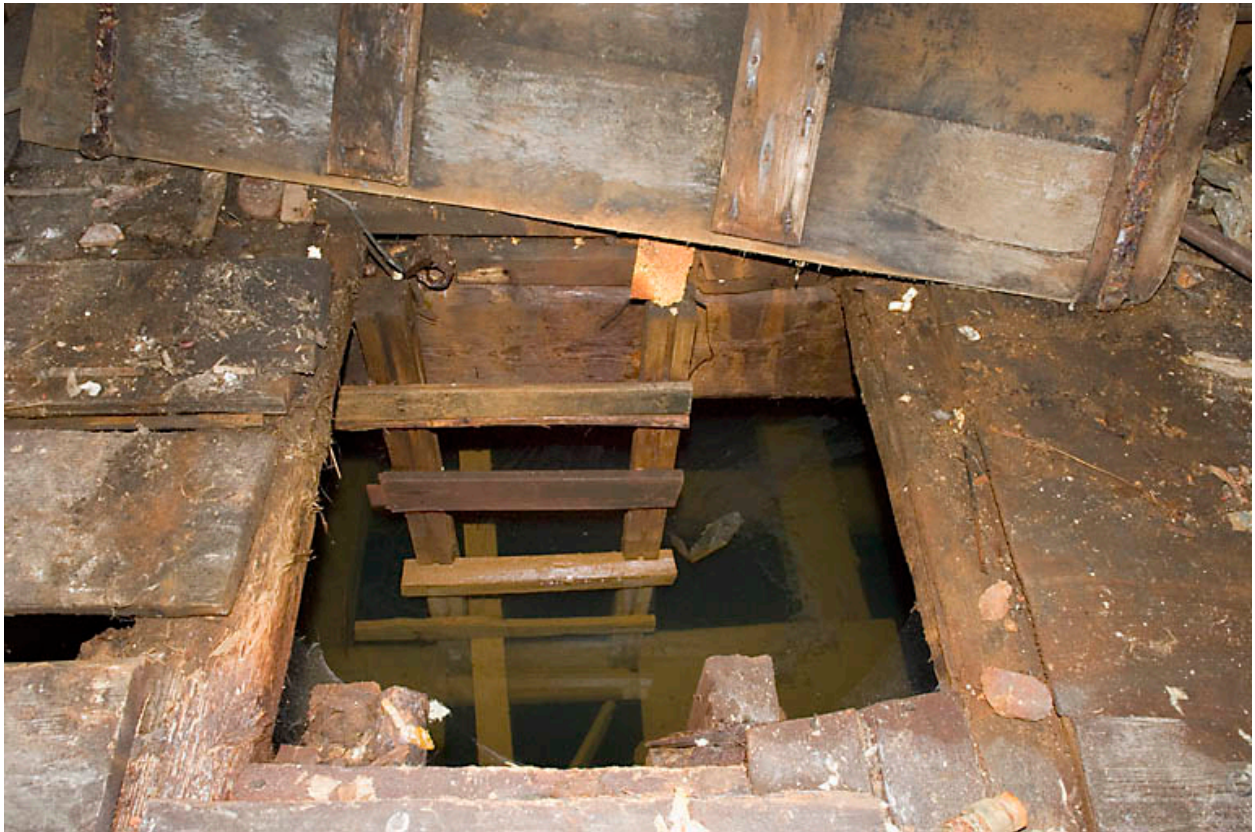
Grenier à sel. Trappe d'accès à la cuve des Allemands (2006).
