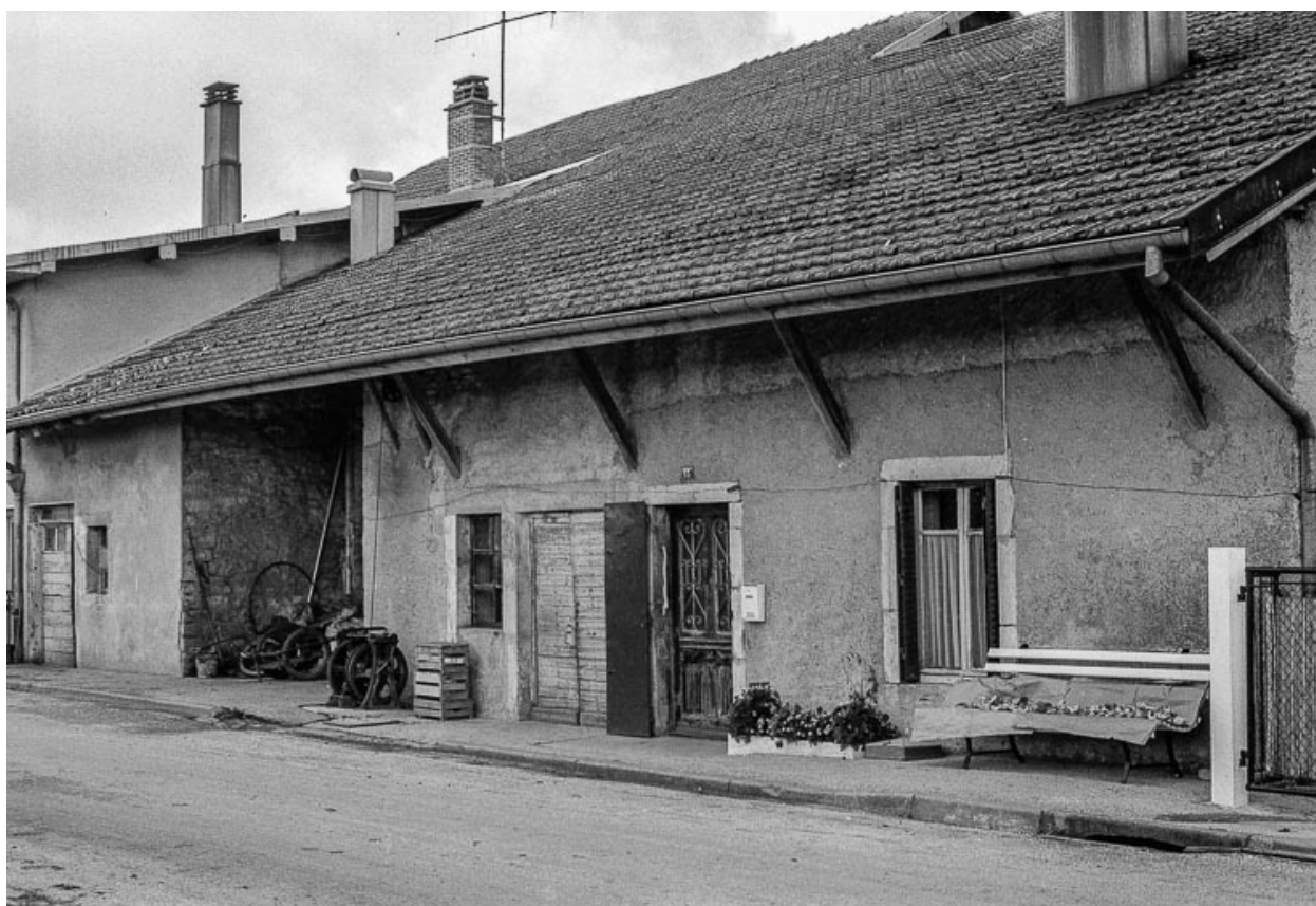
Ferme située 13 rue du Moutet : façade antérieure.
