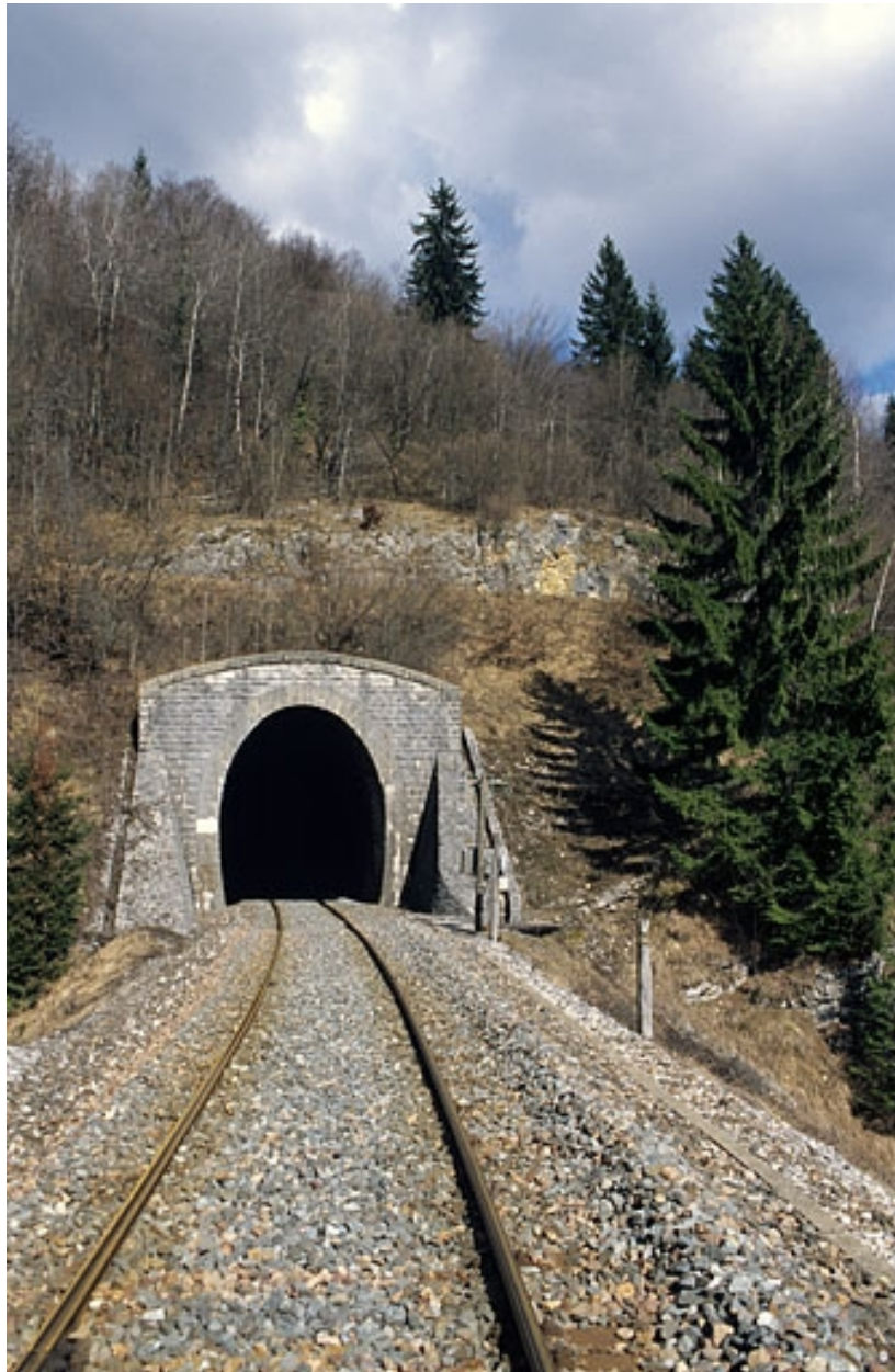
Tunnel : tête côté La Cluse (ouest).
