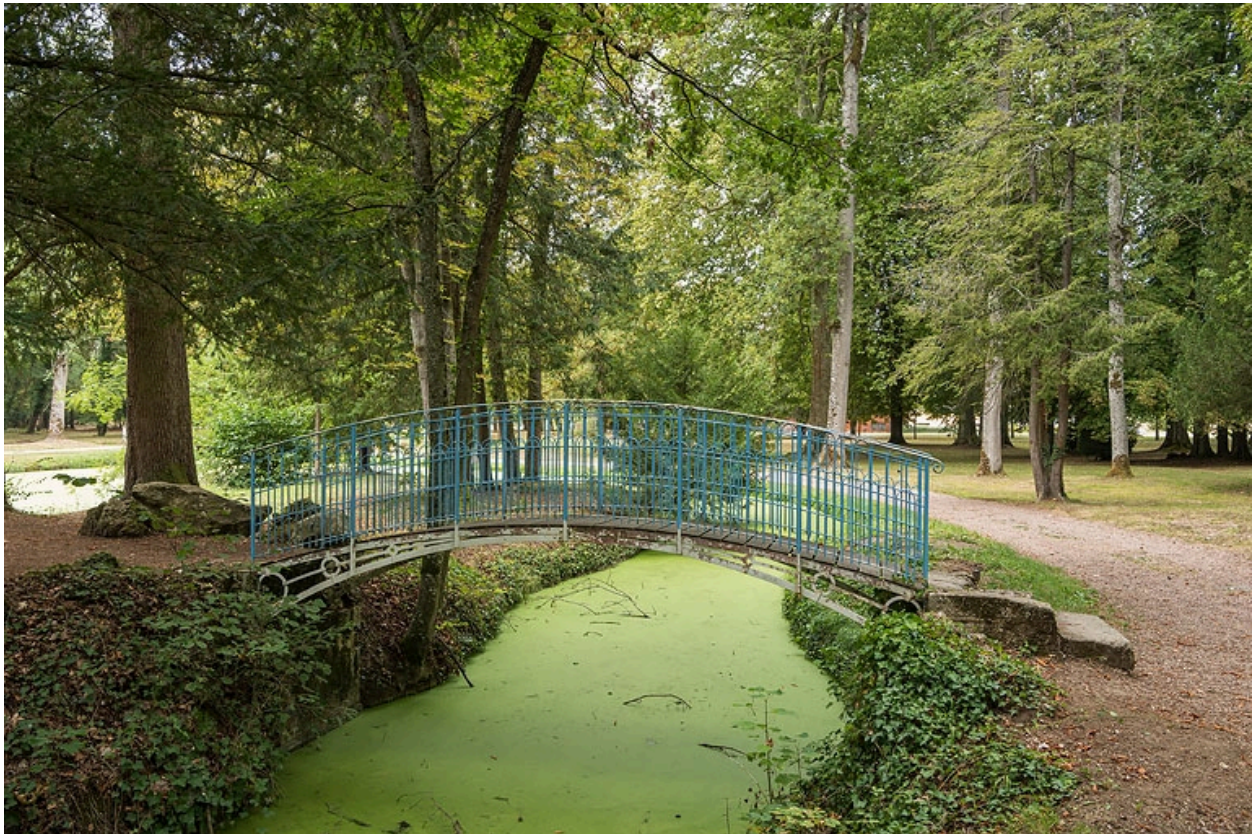
Passerelle métallique donnant accès à l'île.
