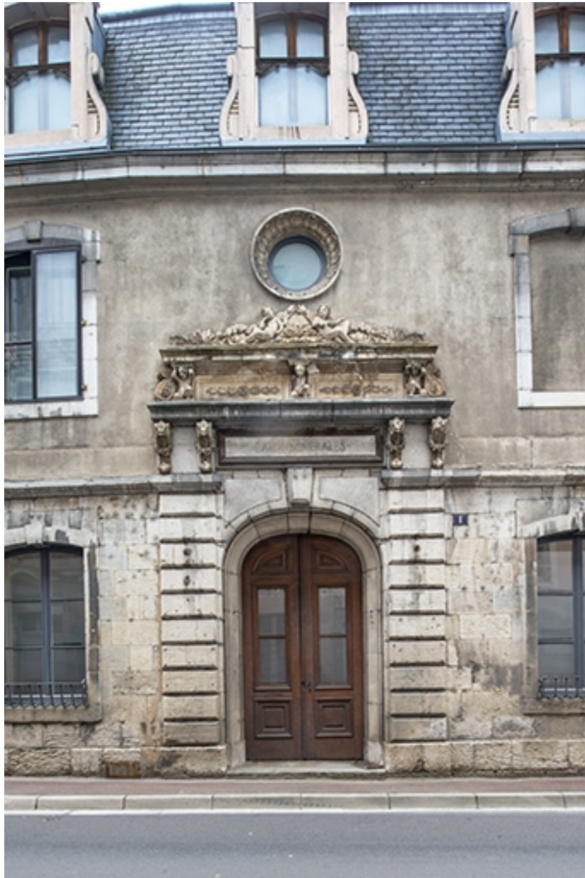
Façade est, portail d'entrée.
