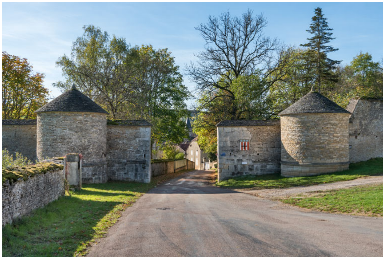
Vue d'ensemble des tours à l'entrée ouest.
